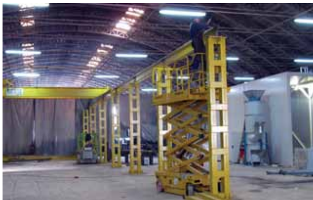
Izdelava mostnega dvigala
